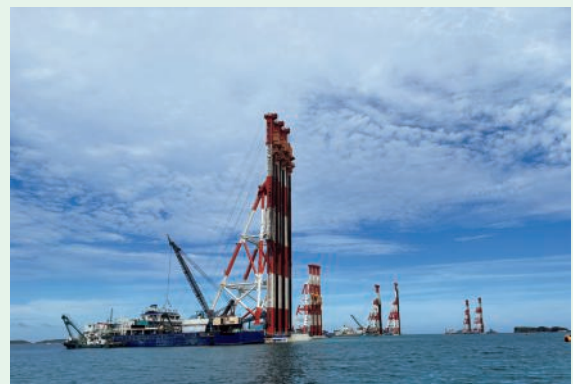
大浦湾で地盤改良工事を施工中の作業船
