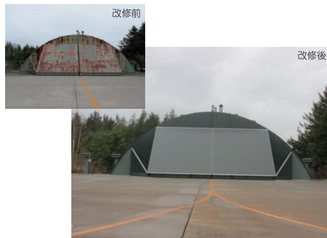
改修したF-15戦闘機用の航空機えん体 (空自千歳基地)
