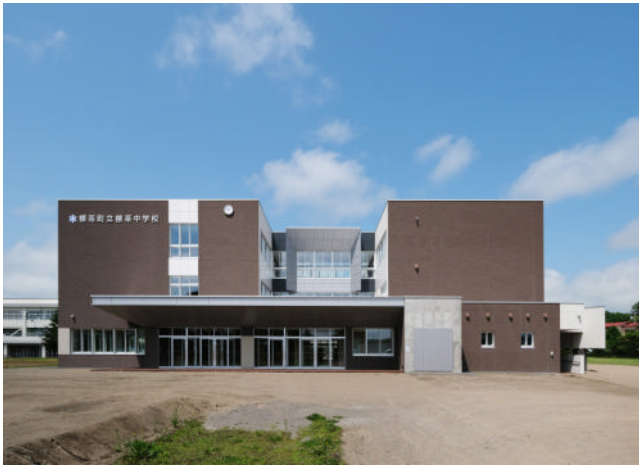
騒音防止工事の助成 (北海道川上郡標茶町標茶中学校)
