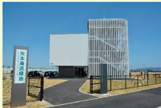
宮城県矢本海浜緑地公園内休養施設 (民生安定施設の助成)
