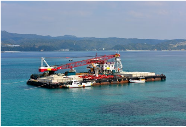
辺野古崎沖合で埋立工事に従事する工事船
