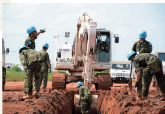
インフラ整備（道路補修）を実施する隊員
