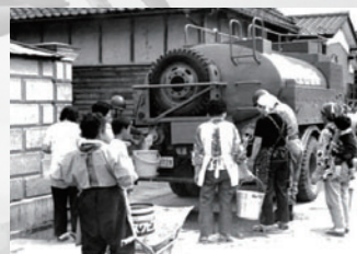
宮城県沖地震にともなう災害派遣で給水支 援を行う隊員(1978(昭和53)年6月)
