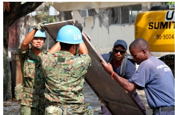
ハイチの作業員とともに瓦礫を撤去する陸自隊員
