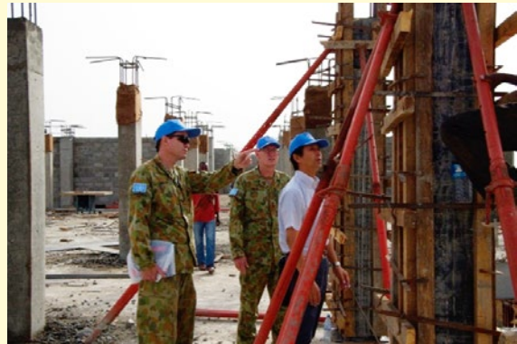
ジュバ大学においてオーストラリア国防軍要員のドレイン中佐（右から2番目）とローソン伍長（左から1番目）が、現地支援調整所の技官とともに、法学部校舎の建設の進捗状況を視察している様子
