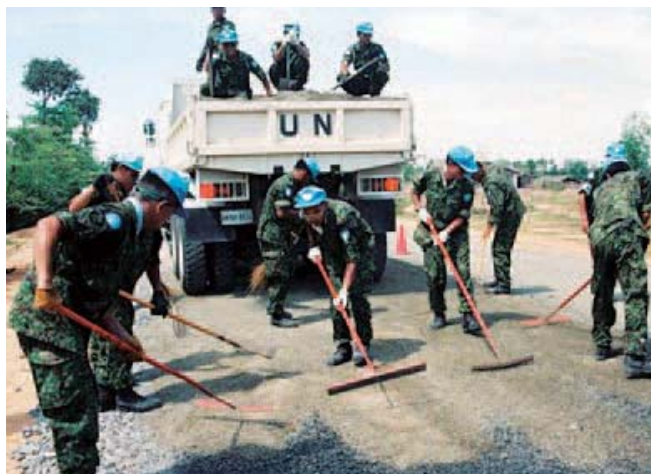
カンボジアで簡易舗装の道路を構成する陸自施設部隊(93(平成5)年) 陸自施設部隊は、道路のべ約100km、橋約40か所の補修を行った。
