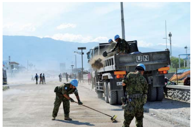
ハイチにおいて道路の補修作業を行う陸自隊員
