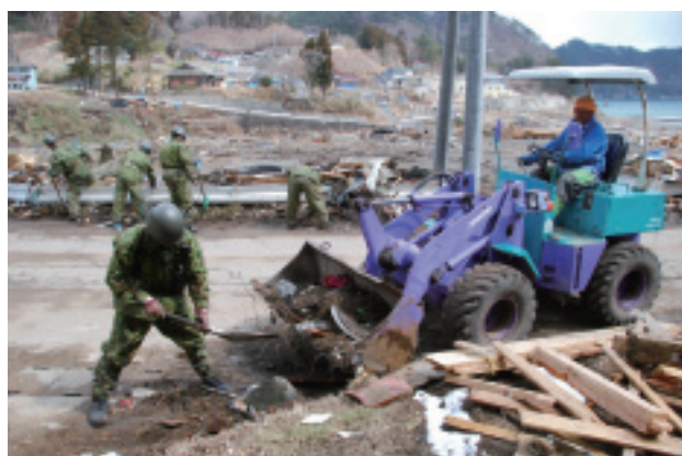
道路の復旧・瓦礫除去
