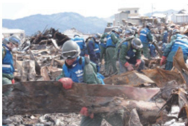
瓦礫除去など復旧作業
