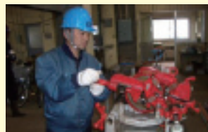
ボイラー蒸気配管補修
