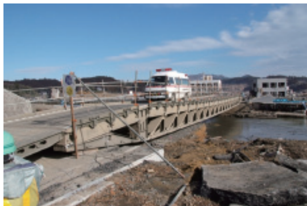
自衛隊の装備品（パネル橋）を代用した応急的な橋梁
