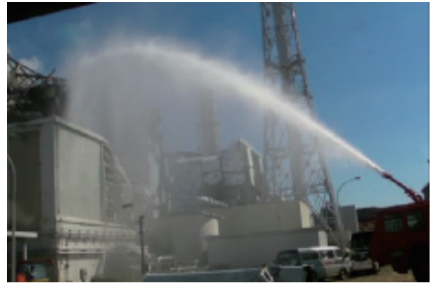
地上からの放水の様子
