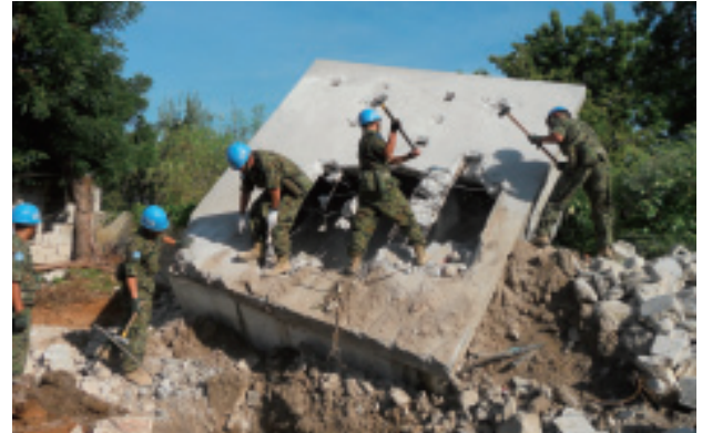
メトロポールハイチ大学の解体・瓦礫除去
