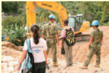
日本のNGOと連携して整地作業を実施
