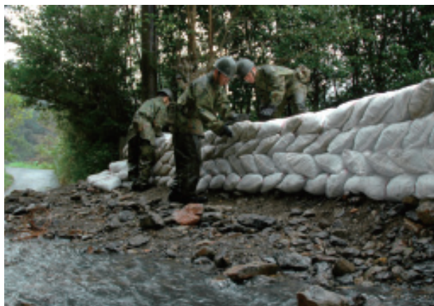
2次災害防止のため土嚢を積む隊員（奄美大島）
