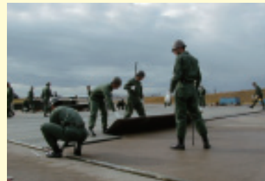
滑走路被害 復旧訓練
