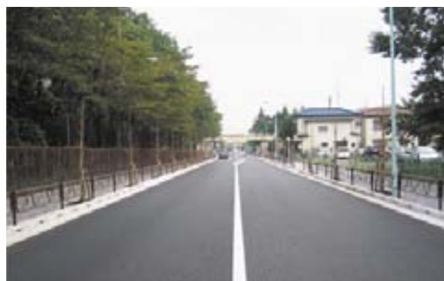
基地周辺対策として道路改修を行った 羽村市道201号線
