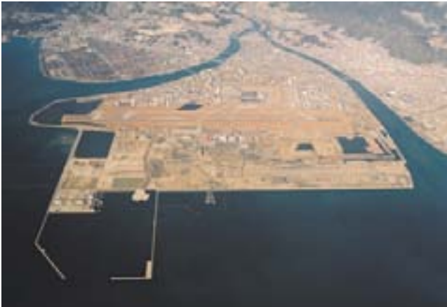
滑走路移設工事の進む岩国飛行場
