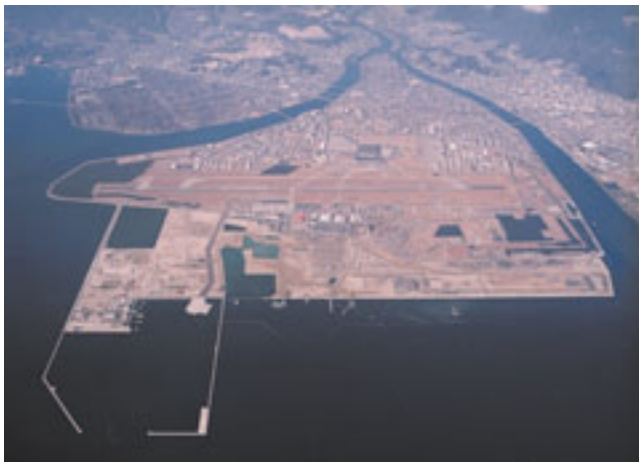
岩国飛行場（滑走路移設工事着工中）
