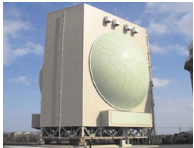
運用研究中のFPS-5（開発試作機）レーダー（千葉県） （画面中央下部は隊員）
