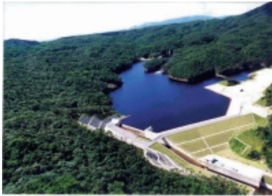
周辺障害防止対策事業の一環で建設された沖縄県名護市の久志大川ダム
