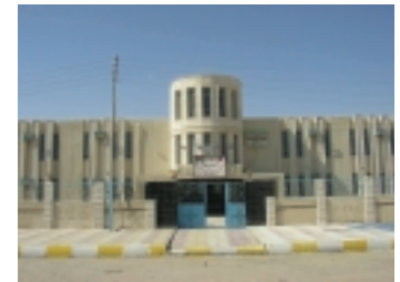
完成したアル・ハッティーン小学校
