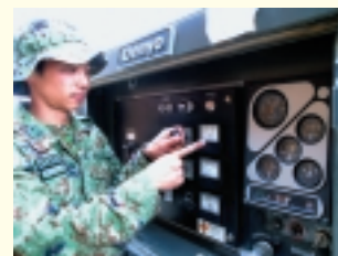
発電機を点検する鬼島2等陸曹
