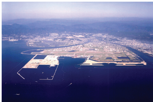
移設工事が行われている岩国飛行場
