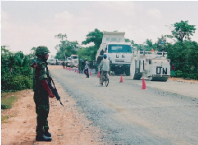
カンボジアにおいて道路修理中の陸自派遣部隊
