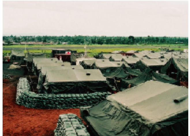
ザイール(当時)において宿営地内の天幕の周囲に処置した防護のための土のう積み
