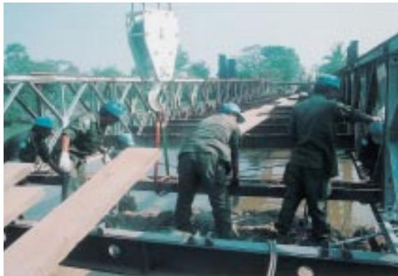
橋が破壊された河川に橋を新たに構築中のUNTAC 1次隊
